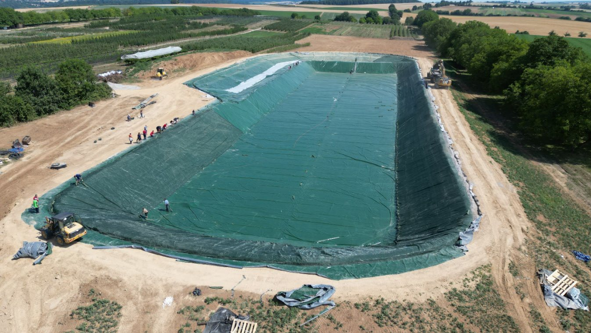
Einbringen des Wallschutzgewebes
