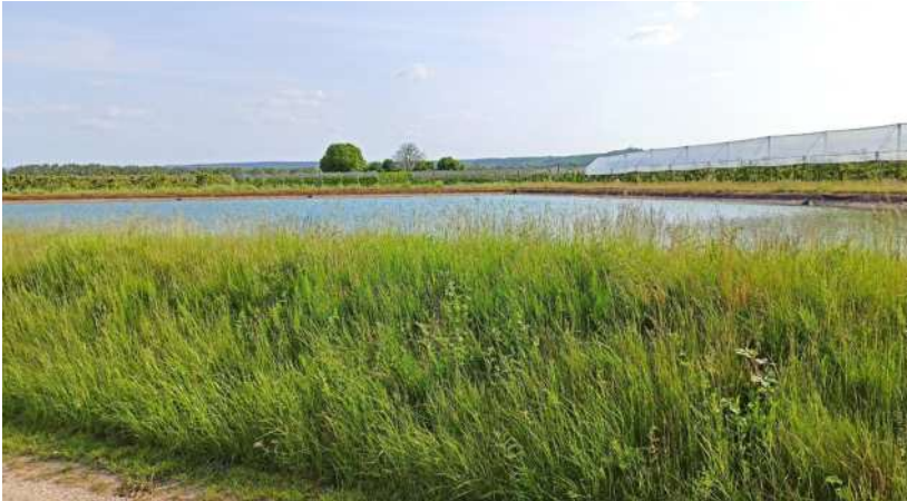
Anlage eines Wasserspeichers unmittelbar neben Obstplantagen
